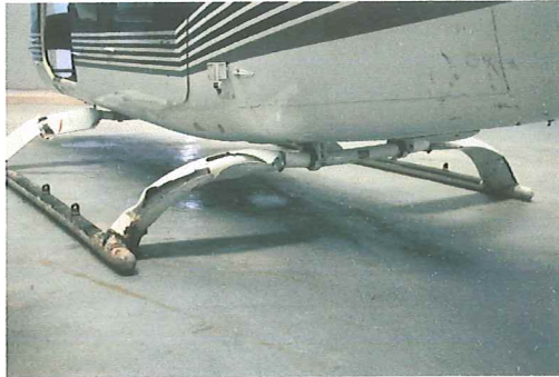
Daño severo en la estructura, por impacto Directo contra el terreno.
